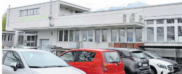
Der Ort, von dem Nera nicht mehr alleine herunterkam: das Vordach im Gewerbepark Widen.
